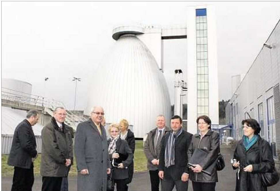
Der Faulturm ist das Herzstück des Kraftwerkes Klärwerk in Gera-Stublach. Nach der Erneuerung der Blockheizkraftwerke kann sich das Klärwerk nun mit Unterstützung der Bioenergieregion Thüringer Vogtland vollständig mit selbst produziertem Strom und Wärme versorgen. (Foto: OTZ/Angelika Munteanu)
