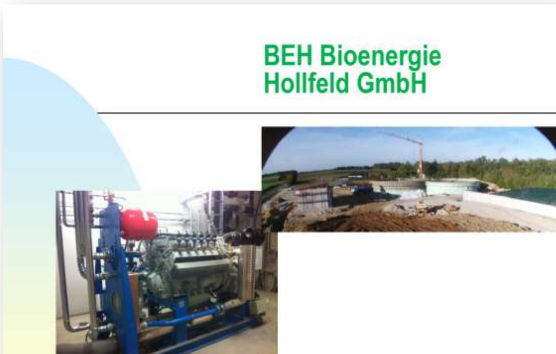
Abbildung 13: Die Biogasanlage der BEH Hollfeld GmbH ist eines von vier Projekten deren Machbarkeit mit finanzieller Unterstützung der Bioenergieregion Bayreuth geprüft wurde. Die Abwärme der Biogasanlage wird über ein Fernwärmenetz in das Nahwärmenetz des Biomasseheizwerks Hollfeld eingespeist. Hierdurch werden mindestens 70.000 Liter Heizöl eingespart und zusätzlich 3.300 MWh Strom umweltfreundlich produziert.
